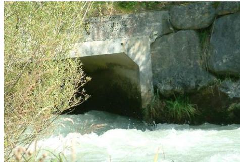
**Figure 4 : siphon au niveau de la sortie piscicole (entrée hydraulique) de la rivière de contournement**
